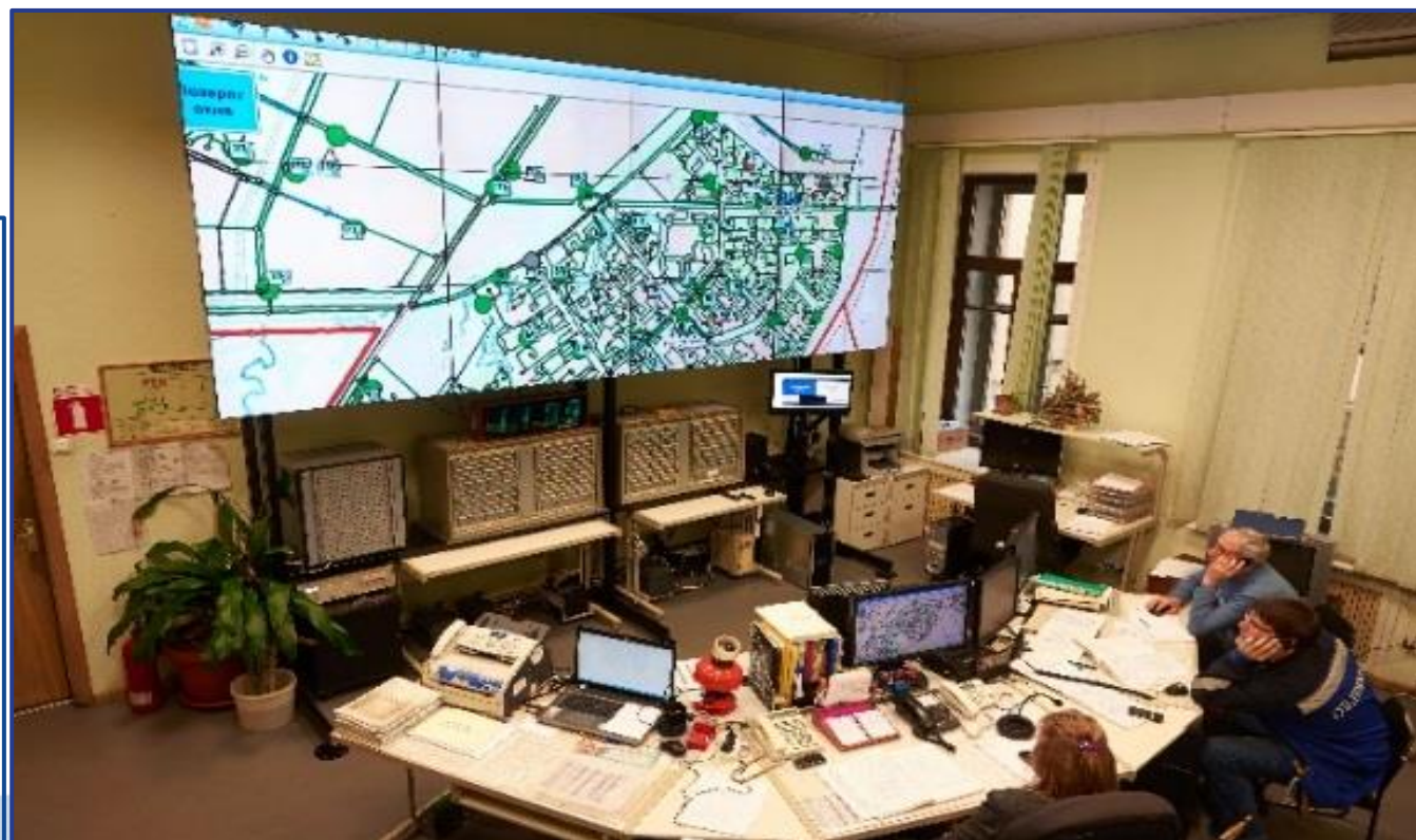
Центральный диспетчерский пункт АСУНО «Аврора»
