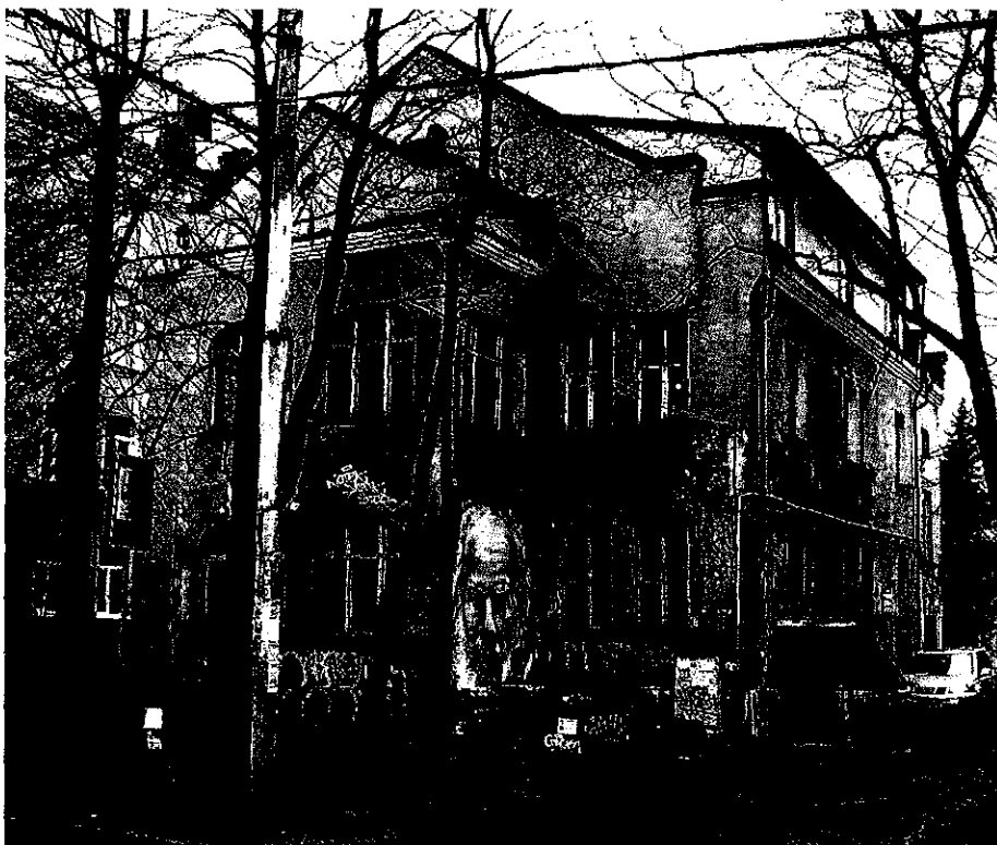
Фото 1. Восточный и северный фасады.
