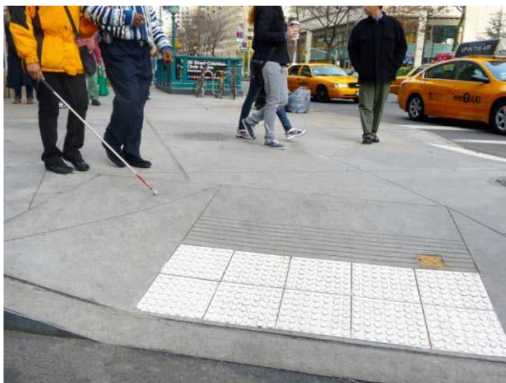
Рисунок 26. – Пример пандуса со скошенными боковыми гранями
