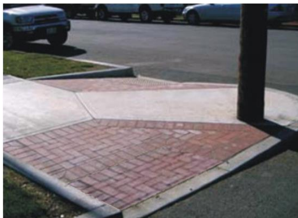
Рисунок 28. – Пример пандусов с бортиками
