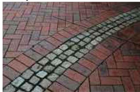
ТИП 2 клинкерная плитка Penter Klinker "Artland", размер 200x100x52 завода производителя "Wienerberger" и ТИП 4 Penter Klinker "Dresden", размер 200x100x52 завода производителя "Wienerberger"
