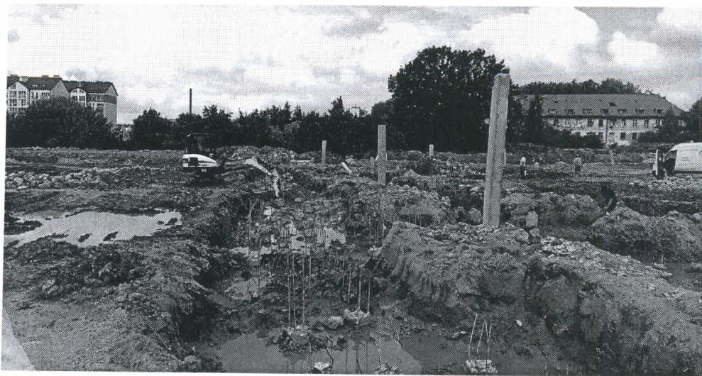
Фото № 1 Общий вид участка работ
