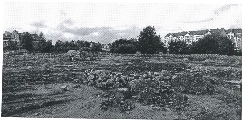
Фото № 2 Общий вид участка работ
