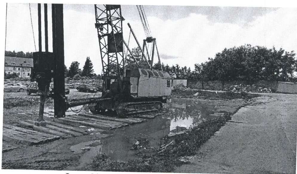
Фото № 3 Общий вид участка работ
