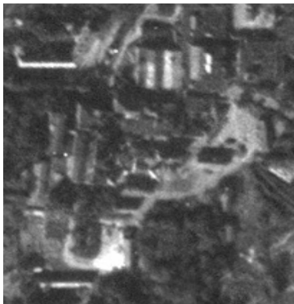
Илл. 7. Фрагмент британской аэрофотосъемки, 1944. Планировка корпусов пивоварни «Понарт» (нем. – «Brauerei Ponarth») Отдельно стоящее здание в центре площади – здание конюшни.
