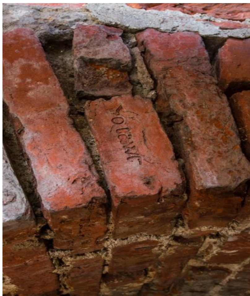
Илл. №№ 1-3. Фрагменты кирпичной кладки кон. XIX в. с производственными клеймами кирпичных заводов Велау, Мигушин, Восточная Пруссия.
