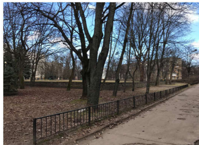
НЕУДОВЛЕТВОРИТЕЛЬНОЕ СОСТОЯНИЕ ПОКРЫТИЙ ПЕШЕХОДНЫХ ЗОН
