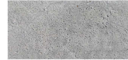
2 НАЛИВНОЕ БЕТОННОЕ ПОКРЫТИЕ
