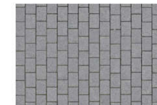
П4 БЕТОННАЯ БРУСЧАТКА (200 X 100 X 80 MM)
