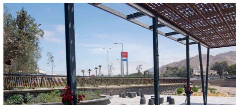
Устройство пространственных конструкций, позволяющих укрыться от солнца и осадков
