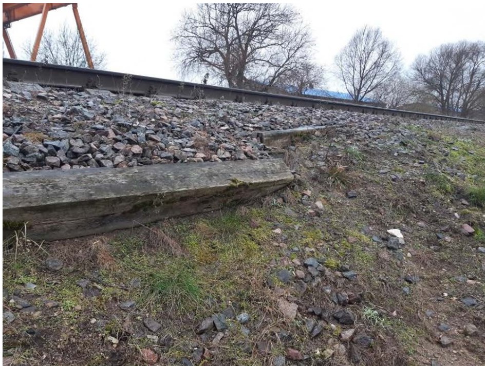
Рисунок 2. Недостаточная ширина обочины земляного полотна на ПК 501.
