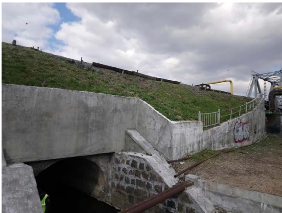
Рисунок 3. Недостаточная ширина обочины земляного полотна на ПК 17+60 Вид по ходу пикетажа.
