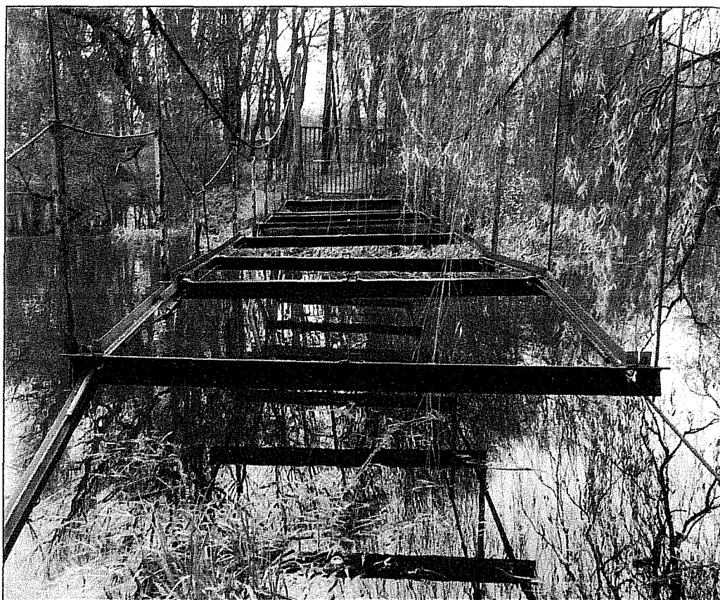
Фото 8, мост через пруд в аварийном состоянии
