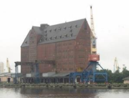
Здание портового склада, 1942 г.
