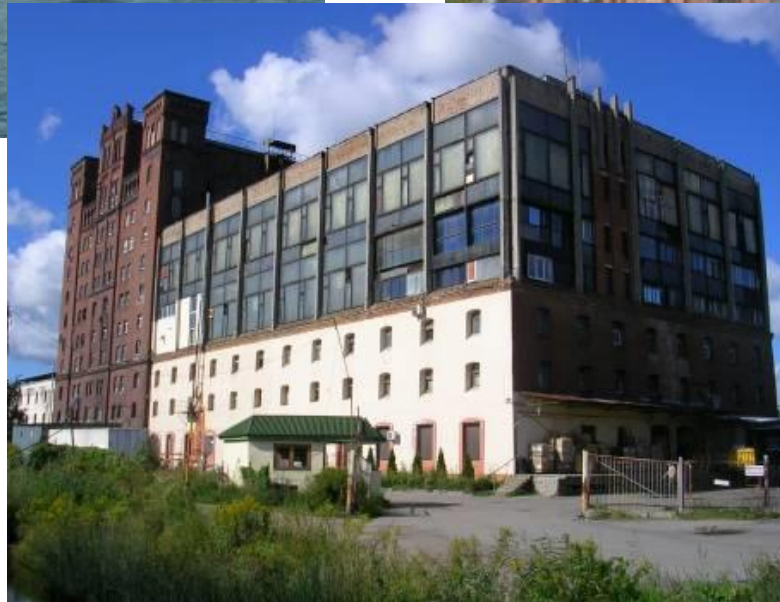
Здание элеватора, 1897 г.
