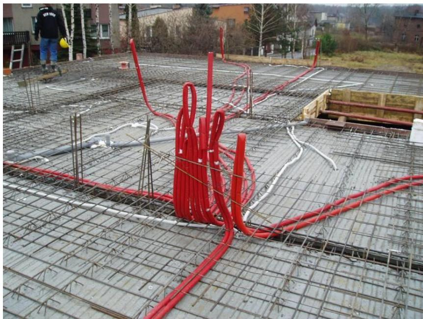
Дополнительное нижнее армирование для предотвращения образования трещин
