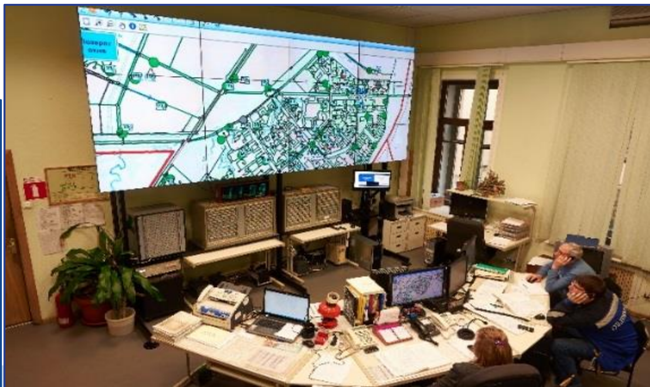
Центральный диспетчерский пункт АСУНО «Аврора»
