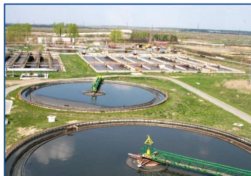
Очистные сооружения водоканалов.
