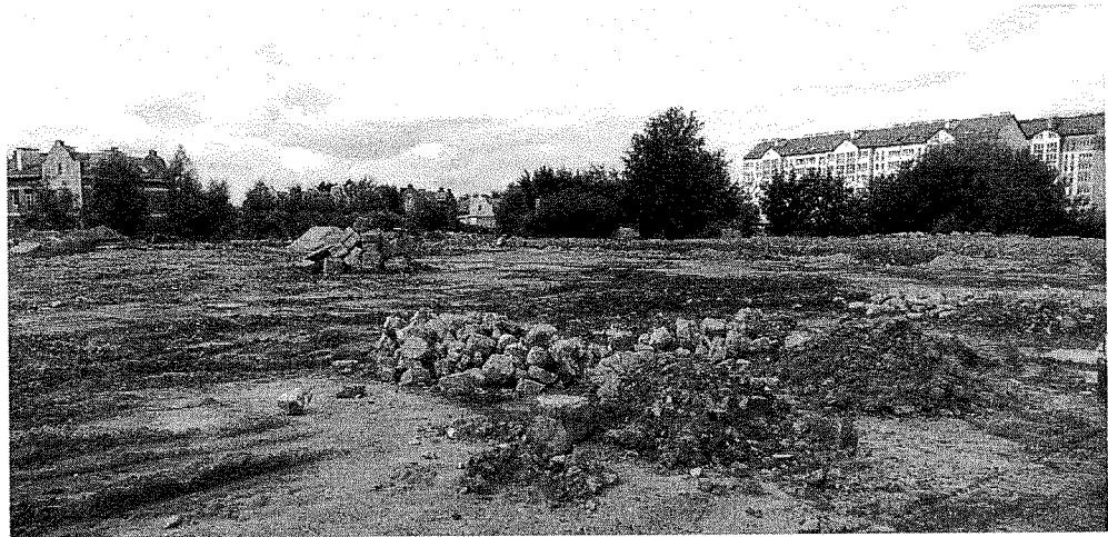
Фото № 2 Общий вид участка работ
