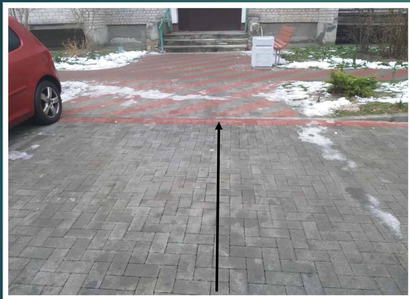
Понижение бортового камня
