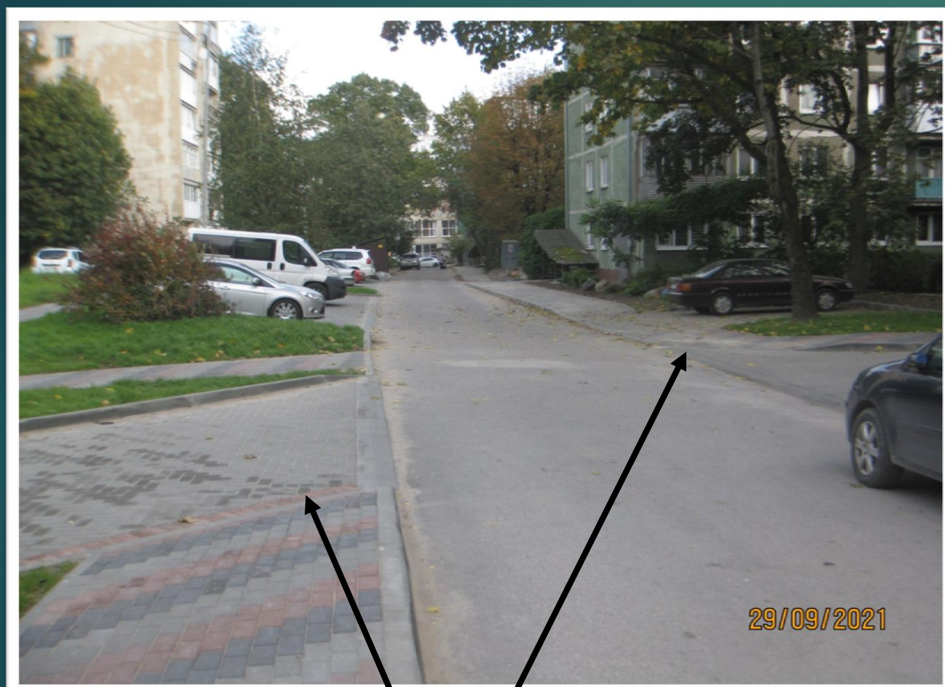
Понижение бортового камня
