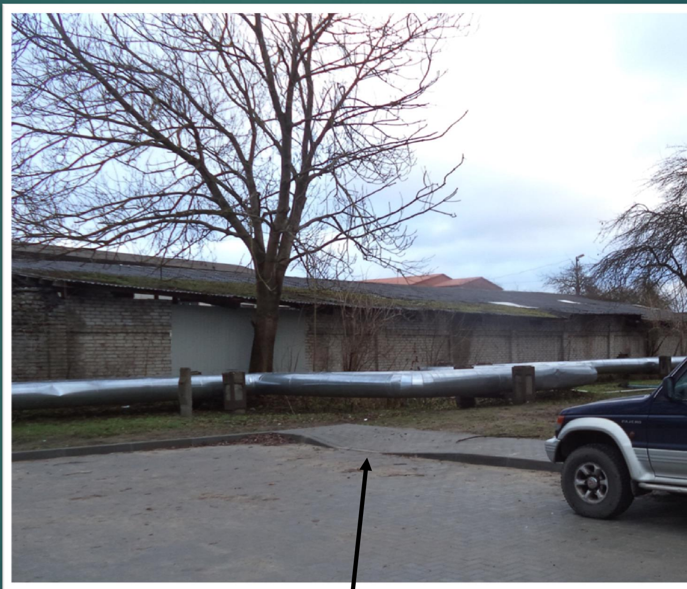
Понижение бортового камня
