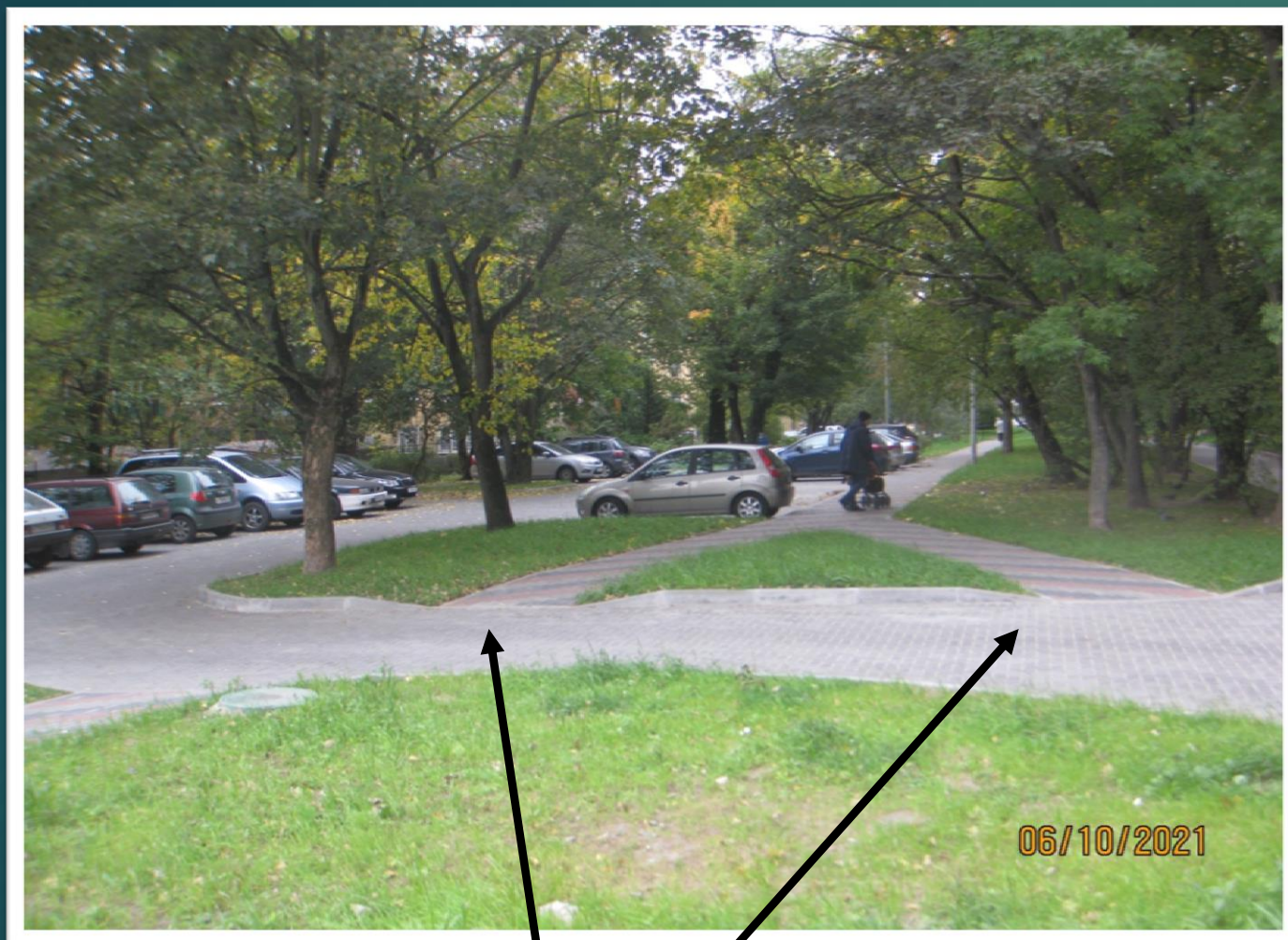
Понижение бортового камня
