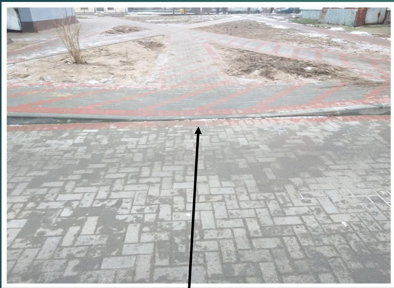
Понижение бортового камня
