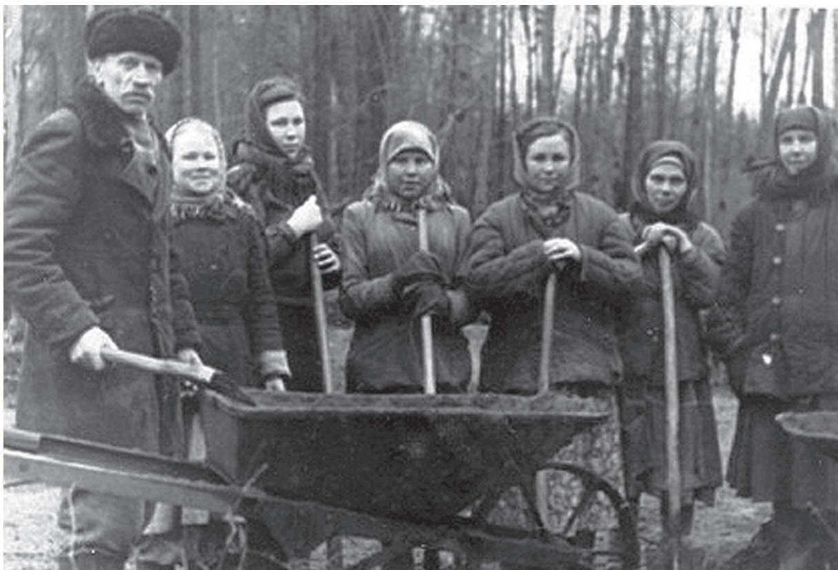
Переселенцы-колхозницы посёлка Ильичёво на ремонте дороги Ильичёво–Саранское. Дорожный мастер В. Кондратьев. 1948 г.
