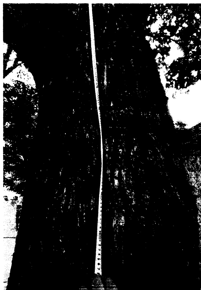
продольная трещина около 2,5 м.
