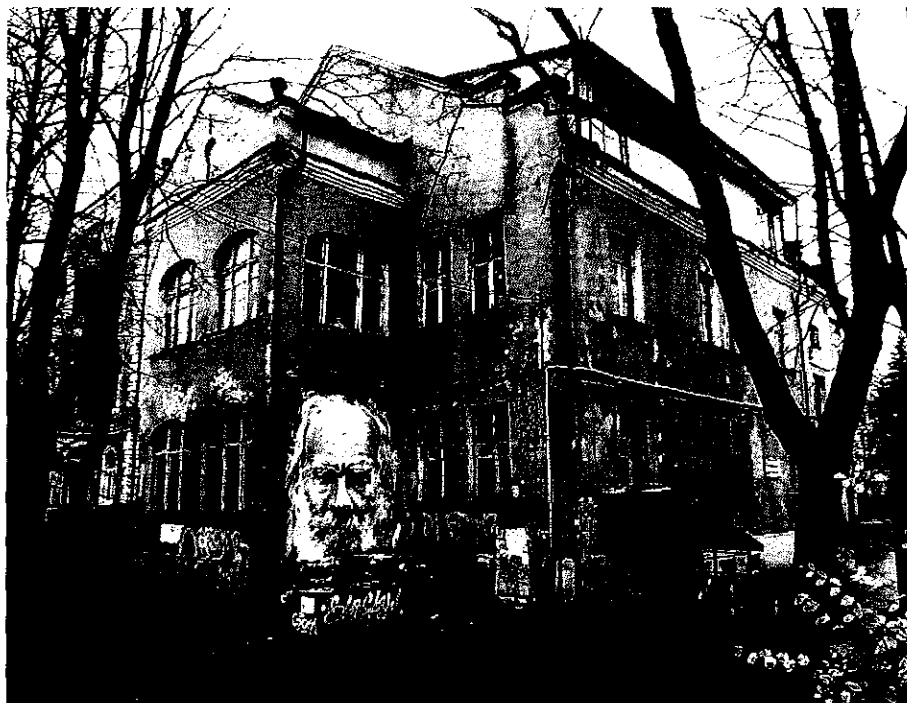
Фото 1. Восточный и северный фасады.
