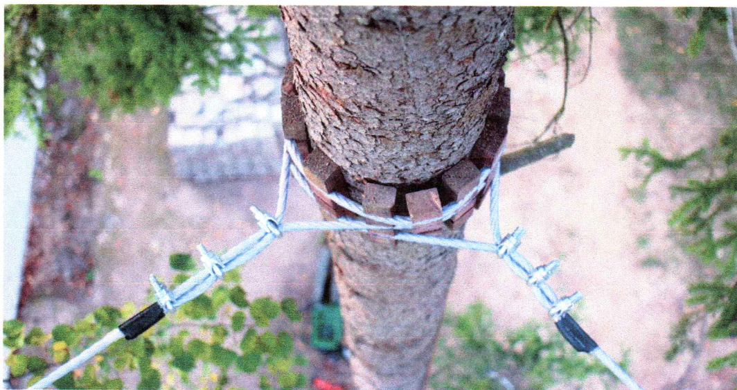
Рис. 1. Механическое закрепление саженцев крупномерных деревьев в грунте: а – вид сбоку, б – вид сверху
